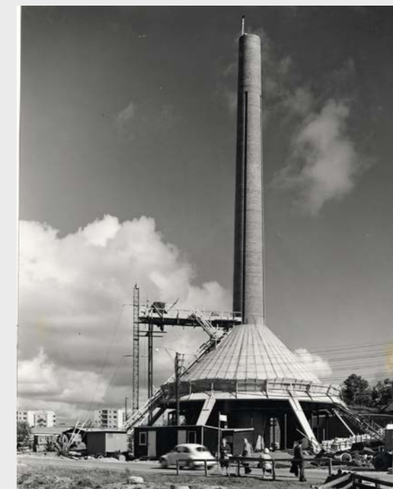
Panncentralen Tratten under uppbyggnad. Sjöstedt 1962
