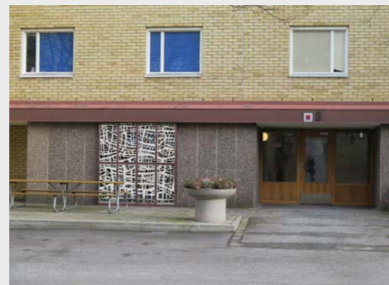
Kv Panelradiator, Garderoben, Skjutfönstret
