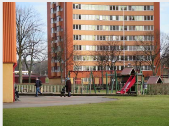
Kv Betongpålen: "Lösiggommarna"
